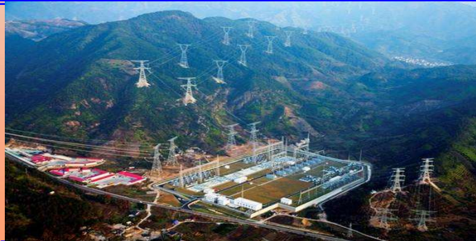
大陸 昌吉—古泉 \pm 1100\text{kV} 特高壓直流輸電
